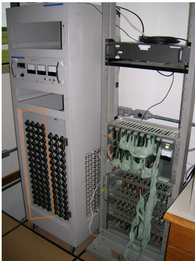
**Figura 4.3 – Fontes de alimentação e sistema de processamento de sinais do detector de muons.**
